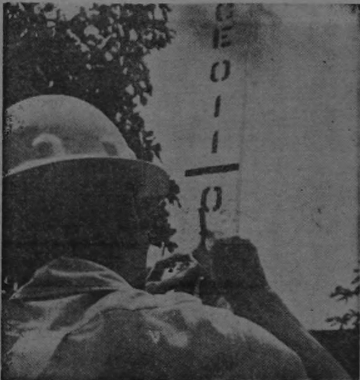
Empleados del ICE han comenzado a numerar los postes de alumbrado público de la ciudad de Quepos.
