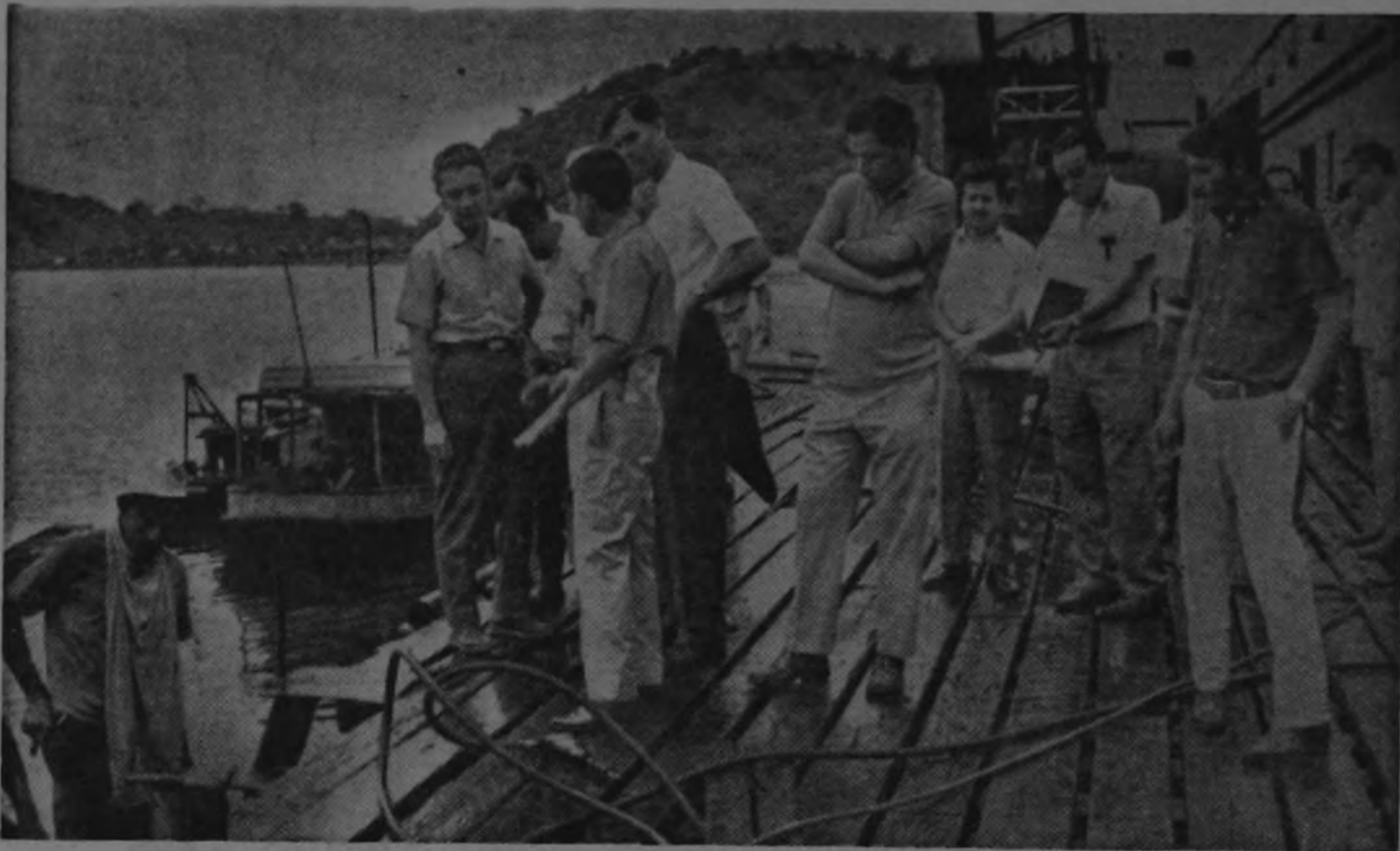
Funcionarios del Ministerio de Obras Públicas y Transportes en visita al muelle de Quepos, inspeccionan sus instalaciones.
